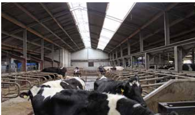
Voorheen was dit het rijpad tussen de bestaande melkveestal (links) en de varkensstal (rechts). De rijweg werd onderkelderd en overkapt. Op deze manier zijn beide stallen met elkaar verbonden. De verbouwing heeft Van Loon volledig in eigen hand genomen.
