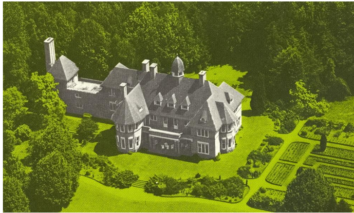
Zonnewende vóór de uitbreiding aan de noordzijde. Links op de foto het ketelhuis. Ten behoeve van de uitbreiding is het ketelhuis gesloopt.
